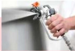
**HEAT SHIELD®** é recomendado para aplicação com espessura seca de 400  $\mu\text{m}$  com 10% de diluição com água potável em concreto, metal, alvenaria, madeira, fibrocimento, cerâmica, plástico (exceto polietileno) e diversos outros substratos, ideal para:
